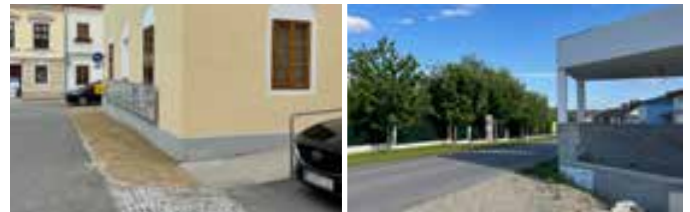
Rechts: Sichteinschränkung durch Altbau, links: Sichteinschränkung durch Neubau - es ist keine Verlängerung des Gehsteiges möglich!
