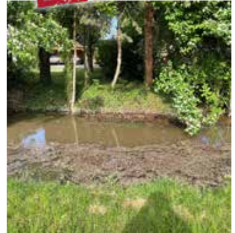
Auffangbecken im Kreuzungsbereich Hilpersdorfer- und Preuwitzer Straße (neben der Pumpstation) sollte dringend vergrößert werden.
