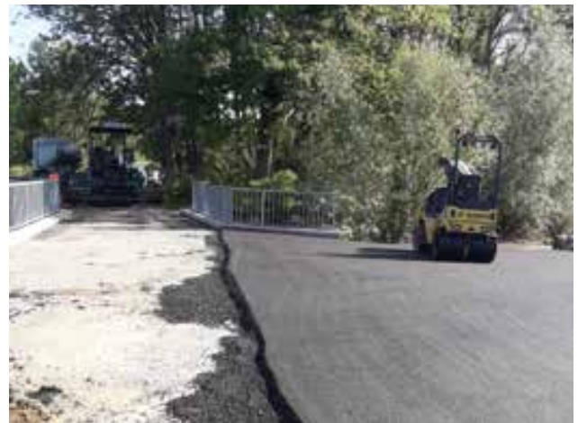
Der Güterweg beim Friedhof in Stollhofen wurde ebenso wie die Mühlbachbrücke asphaltiert.
