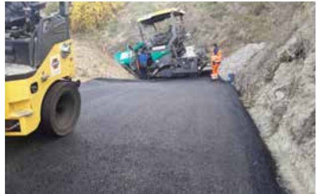
Arbeiten am Güterweg Gießgraben.
