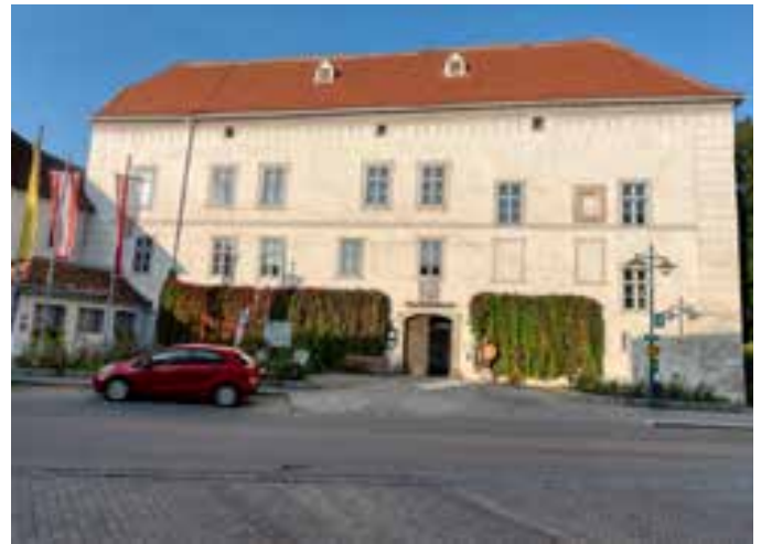
Schon im April forderte das Team der ÖVP den Einbau eines behindertengerechten Personenlifts im Schloss.
